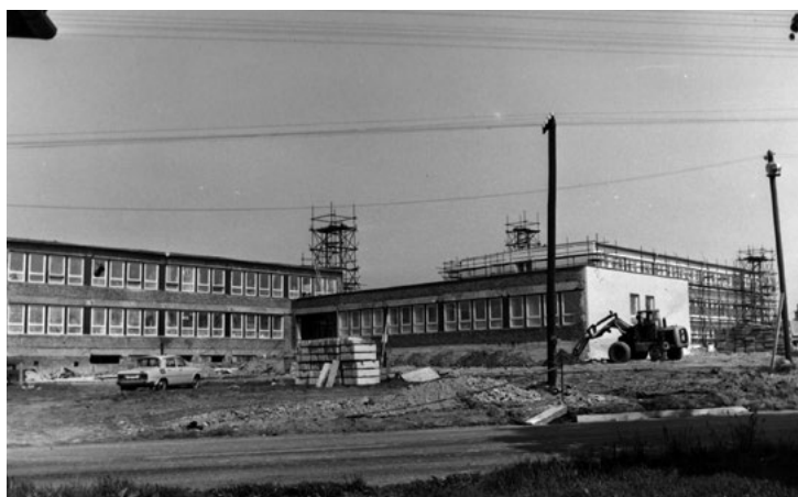
Výstavba budovy školy.
